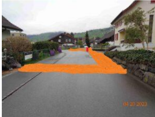
An der Giessenstrasse im Dorf Haag lassen sich aktuell solche vorbildliche Gehwegsanierungen mitverfolgen
