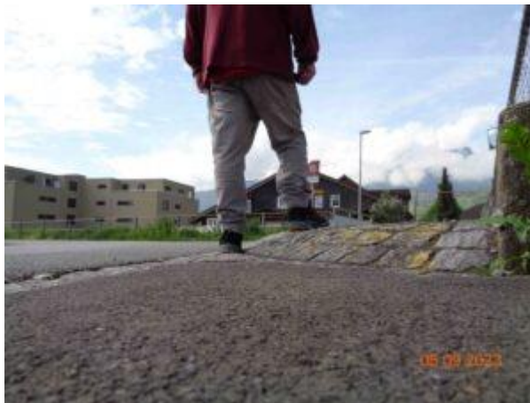
Diese Barrieren-Rampe ist nicht nur für Rollator-Fussgänger eine demütigende Überforderung.
