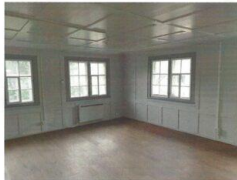
Rückbau Kunstharzfarbe in drei Kammern ca. Fr. 15'000.00 (vollständiger Rückbau resp. Beschädigung bestehender Anstriche kann nicht garantiert werden)
